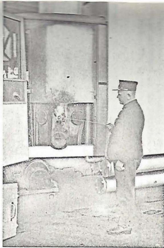
Abb. 9. Einbau des Vergasers im Führersitz. Die Abbildung demonstriert die Einfachheit des Anzündens zur Inbetriebnahme.
