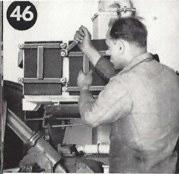
Bild 46. Beim Ausbau der Feinreiniger ist zu beachten, daß die Einsätze nicht verwechselt werden, damit die Dichtungen passend und dicht bleiben.
