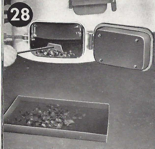
Bild 28. Nach etwa 10maliger Betätigung der Rüttelvorrichtung wird durch die geöffnete Aschetür der Gaserzeuger mit dem Kratzer gründlich entascht.
