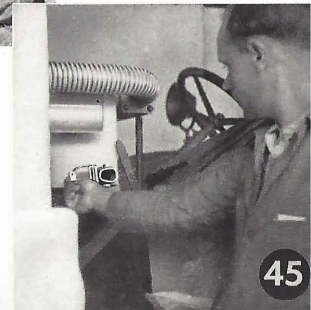
Bild 45. Vorsichtshalber öffnet man auch den Kondenswasserablaßhahn am Feinreiniger, obwohl hier nur selten Wasser niedergeschlagen wird.
