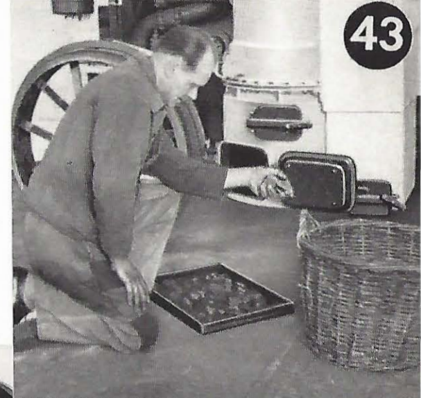
Bild 43. Aus der Holzkohle werden durch Ausschauen die noch verwendbaren Stücke herausgesondert, während der Rest fortgeschüttet wird.
